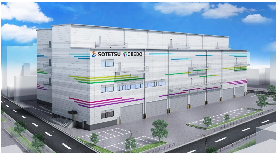
「CREDO 羽村」の外観（イメージ）
